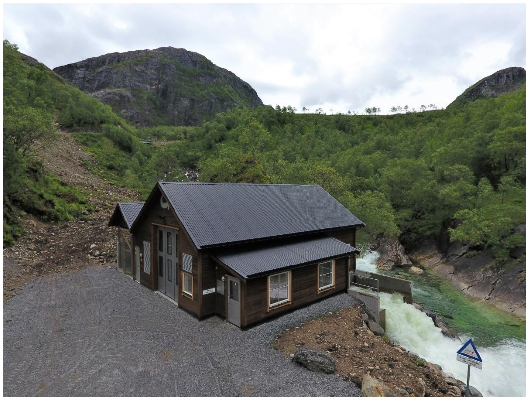
Grytendal kraftverk, Bindal
